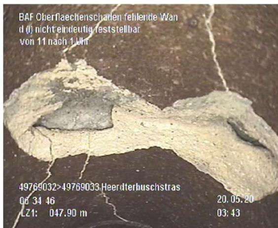
Schadensbild Risse und Abplatzung im Scheitel, fehlende Wandung, Undichtigkeit.
